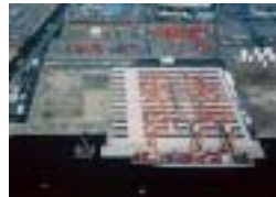
耐震岸壁整備 (名古屋港飛島ふ頭南側コンテナターミナル)
