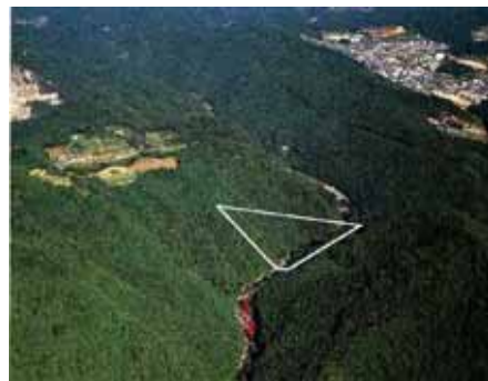
設楽ダム建設予定地
