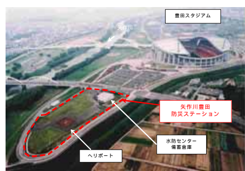
矢作川豊田防災拠点
