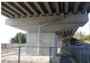
緊急輸送道路上の橋梁の耐震化
