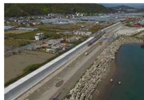
河川堤防・海岸堤防等の整備
