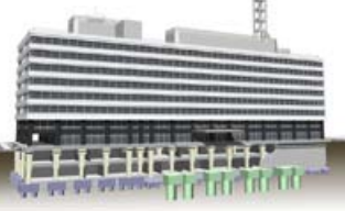
■ 庁舎の耐震化 (名古屋合同庁舎第2号館)
