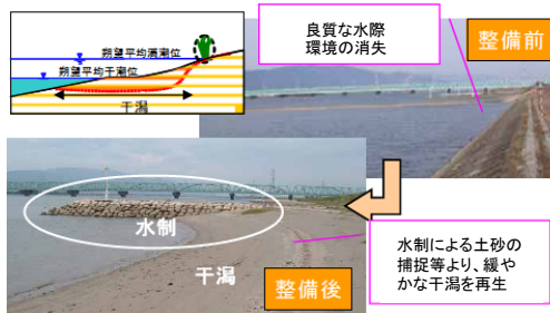
木曽三川下流部自然再生
