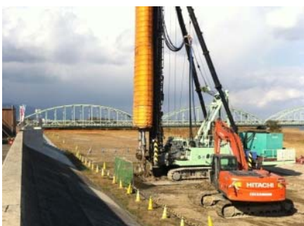
木曾三川下流部堤防
