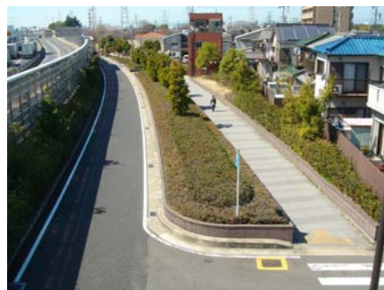
国道23号環境施設帯
