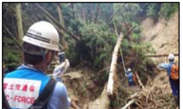
広島土砂災害における被災調査
