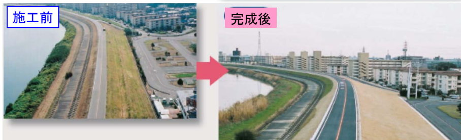
築堤／大治町大字八ツ屋
