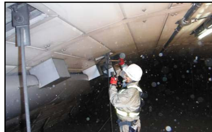
吊り金具点検の様子 (国道19号鳥居トンネル:中部地整)
