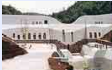
庄内川水系中御所川 市之倉おりべ砂防えん堤
