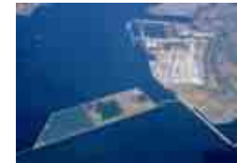
衣浦港(廃棄物海面処分地)
