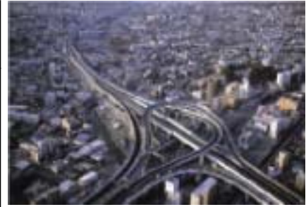
名古屋環状2号線（上社 JCT 付近）
