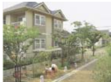
三好ヶ丘団地（三好町） 出典：独立行政法人都市再生機構
