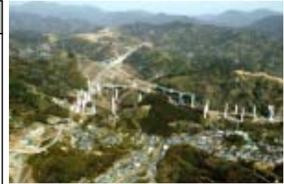
第二東名高速道路 (建設中の吉原 JCT 付近)
