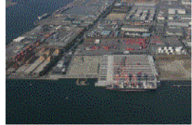
整備の進む大深水コンテナターミナル (名古屋港飛鳥ふ頭南側コンテナターミナル)
