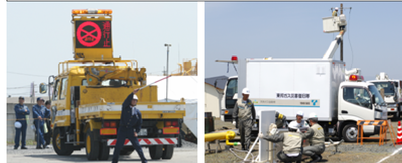
啓開のための道路規制を実施
