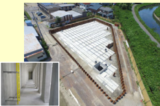
雨水(地下)貯留施設整備 (木曽川水系揖斐川、大垣市)
