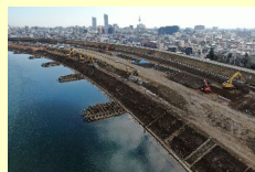
河川堤防の強化 (木曽川水系長良川、中部地方整備局)
