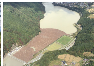
ダム湖流木堆積状況(美和ダム)
