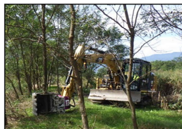
河道内樹木の伐採状況(天竜川)
