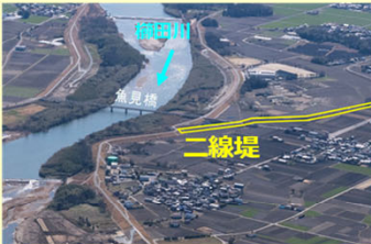
二線堤の保全・拡充 (柳田川水系、中部地方整備局)
