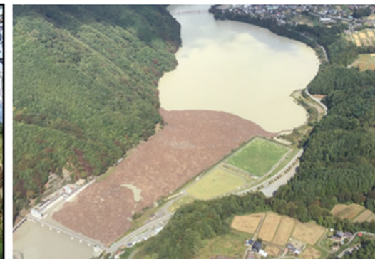
ダム湖流木堆積状況(美和ダム)
