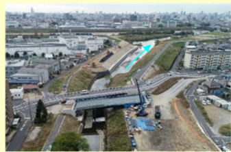
橋梁改築・堤防整備 (庄内川水系、愛知県)
