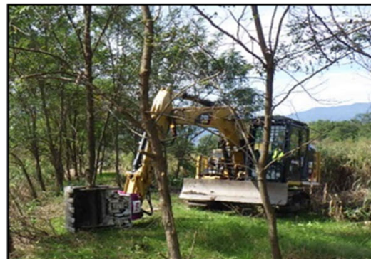
河道内樹木の伐採状況(天竜川)
