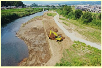
河道掘削 (狩野川水系、中部地方整備局)
