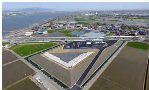
■木曾川 源禄地区河川防災ステーション（H30.5完成） 三重県桑名郡木曾岬町源禄輪中地先
