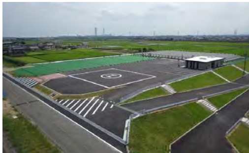
■損斐川 城南地区河川防災ステーション（H26.7完成） 三重県桑名市立田町地先
