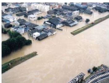
東海豪雨水害(H12.9)
