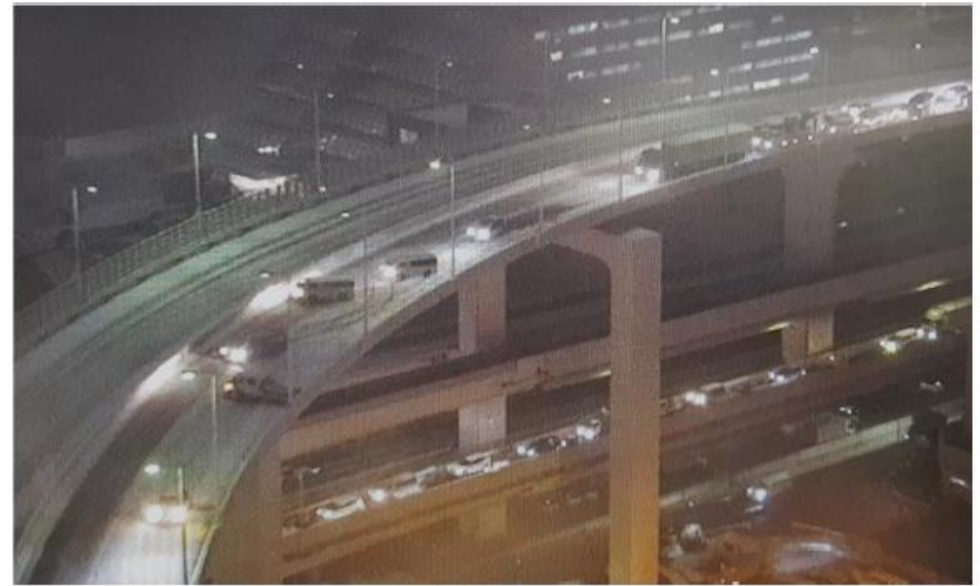
車両の滞留 ＜首都高速道路 台場線＞
