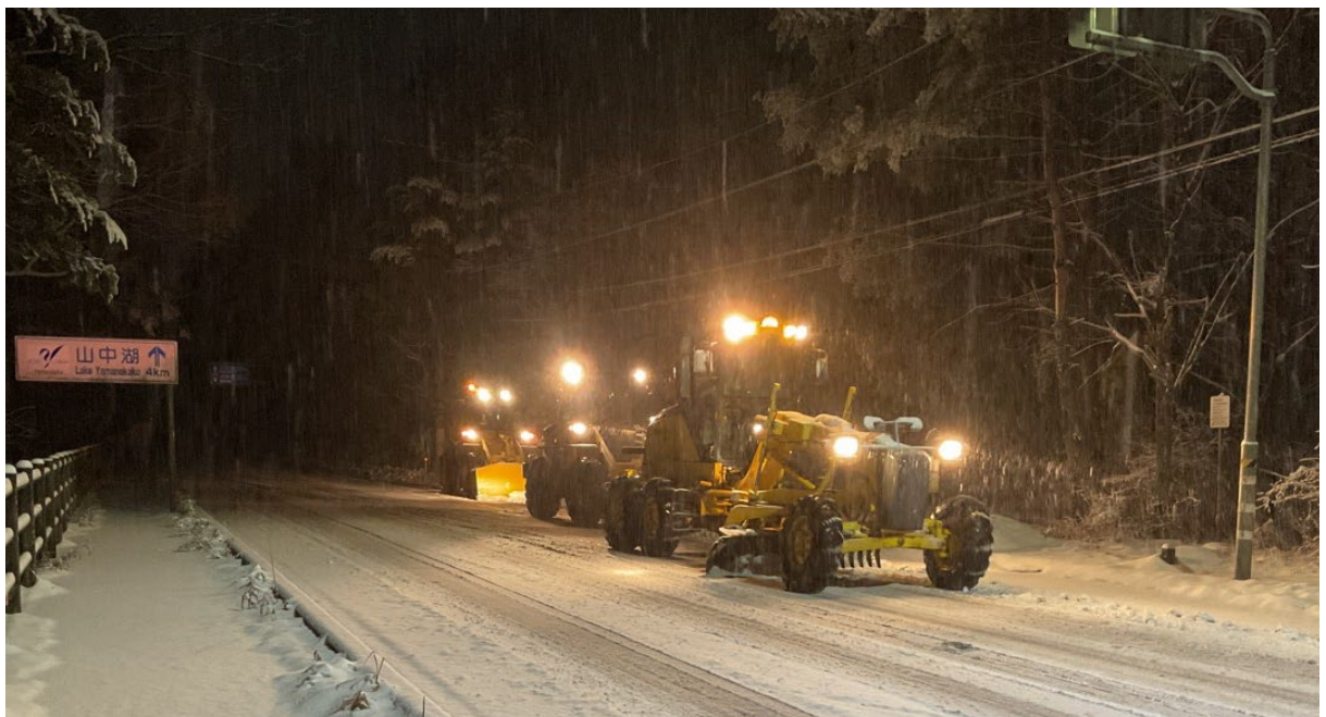
除雪作業状況 (令和6年2月29日 国道138号 山中湖村)
