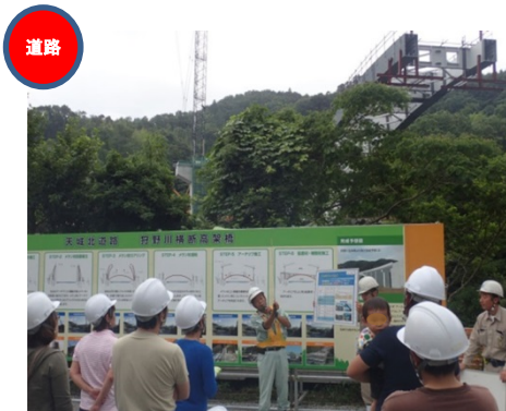
架設工法を地域の皆様に説明（天城北道路）
