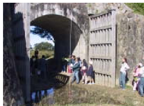
樋門の高さを測る
