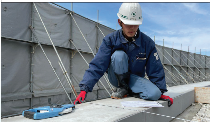
測量の作業状況
