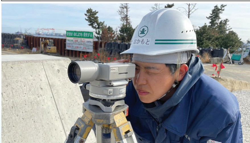
測量の作業状況
