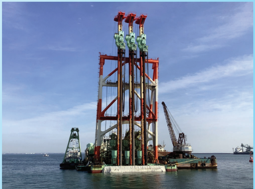
改良工事に使用するサンドコンパクション船団
