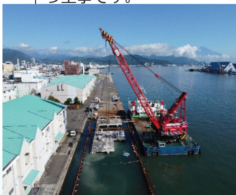
構造物撤去工
