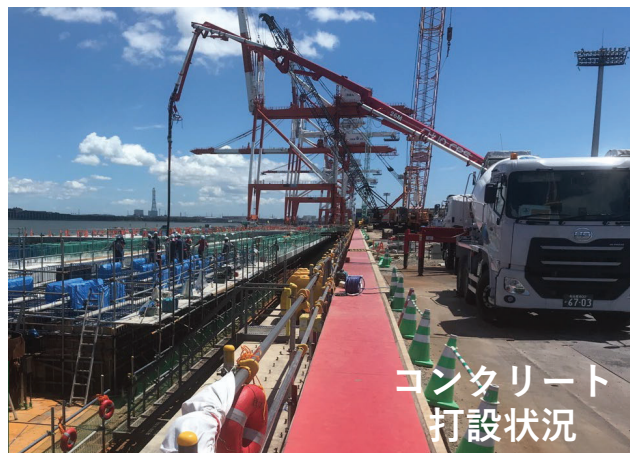
受梁コンクリート
