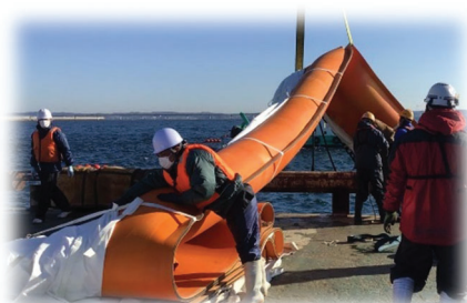
←汚濁防止膜設置状況
