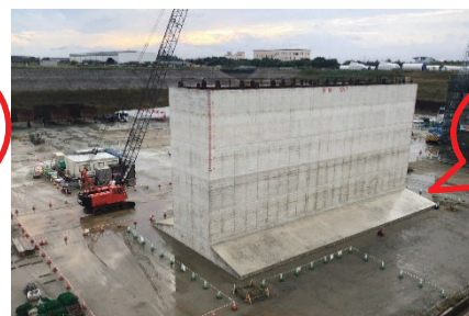
ケーソン製作 ヤード状況
