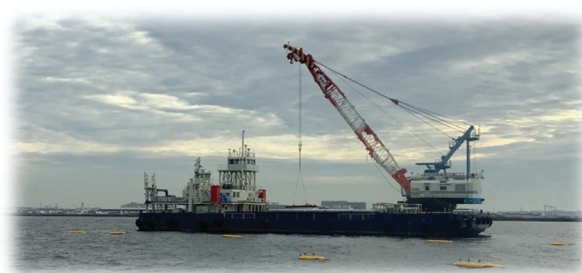
起重機船作業状況→
