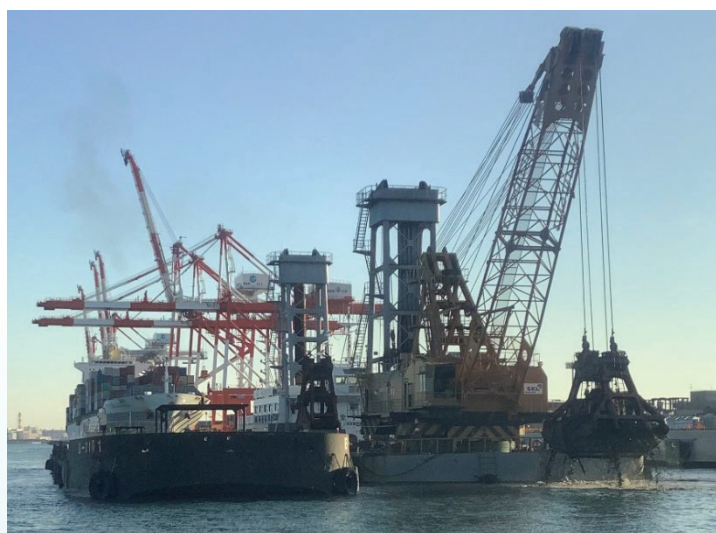
浚渫作業状況
