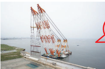
起重機船による HBケーソン据付
