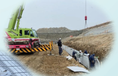
プレキャスト基礎据付状況
