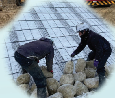
石張工施工状況(AZOT-STONE工法)
