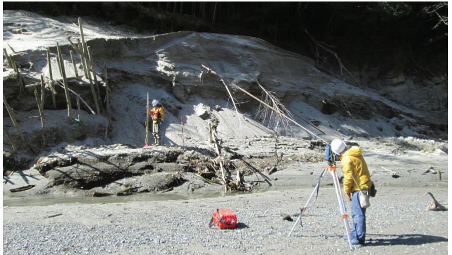
河川測量(水際杭設置)の作業状況
