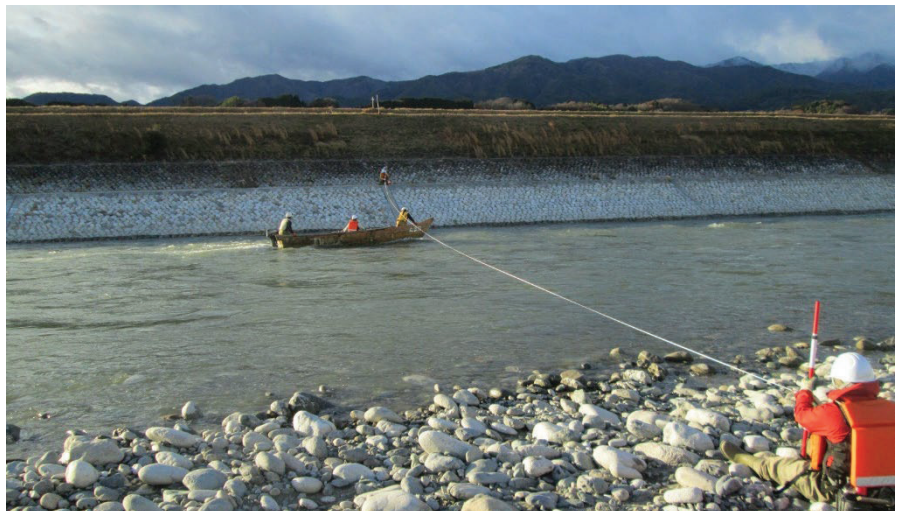
深浅測量の作業状況
