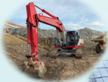
プレキャスト基礎床掘状況
