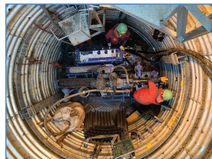
集水ボーリング削孔状況
