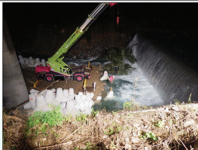
テトラポッド投入状況
