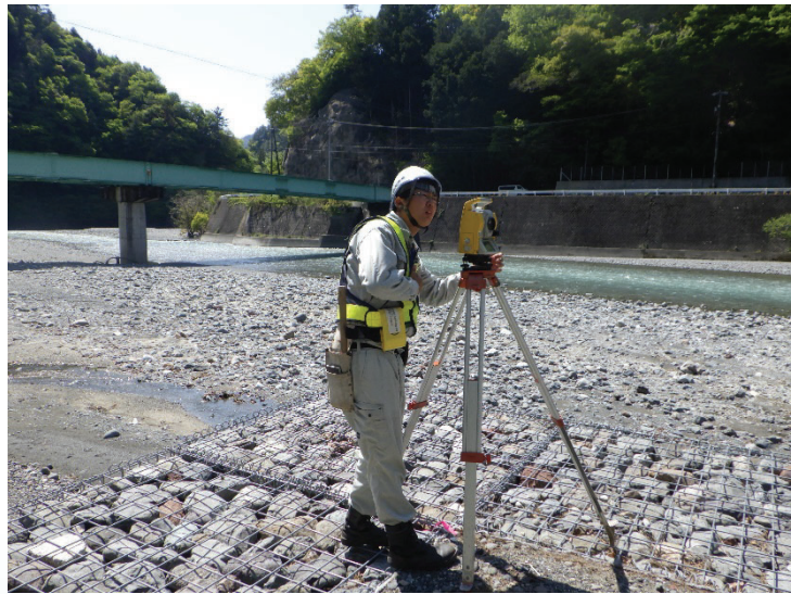
横断測量の作業状況
