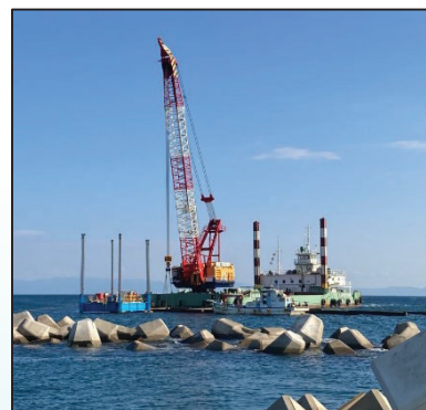
施工中の既設有脚式 離岸堤撤去状況
