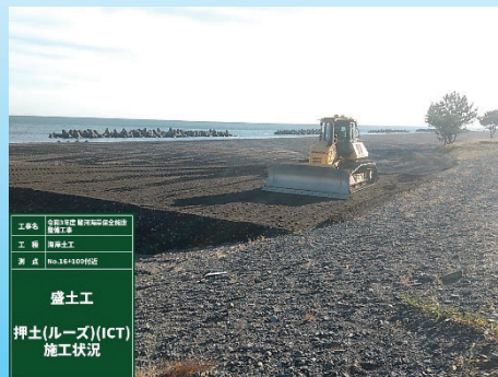
ICT建機による施工状況
