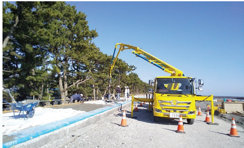
堤防被覆コンクリート打設作業状況
