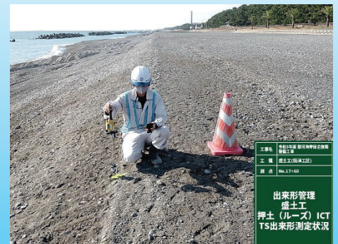
TS出来形管理の作業状況
