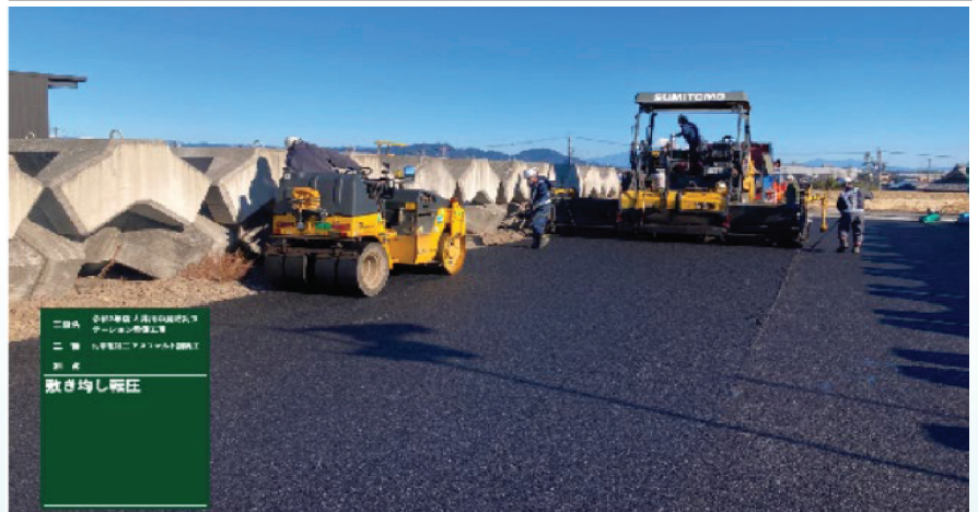
As舗装 基層敷き均し・転圧の作業状況
