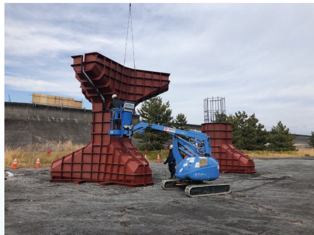
消波ブロック型枠組立の作業状況
