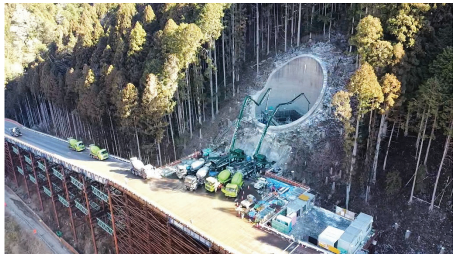
コンクリート大量打設の作業状況
