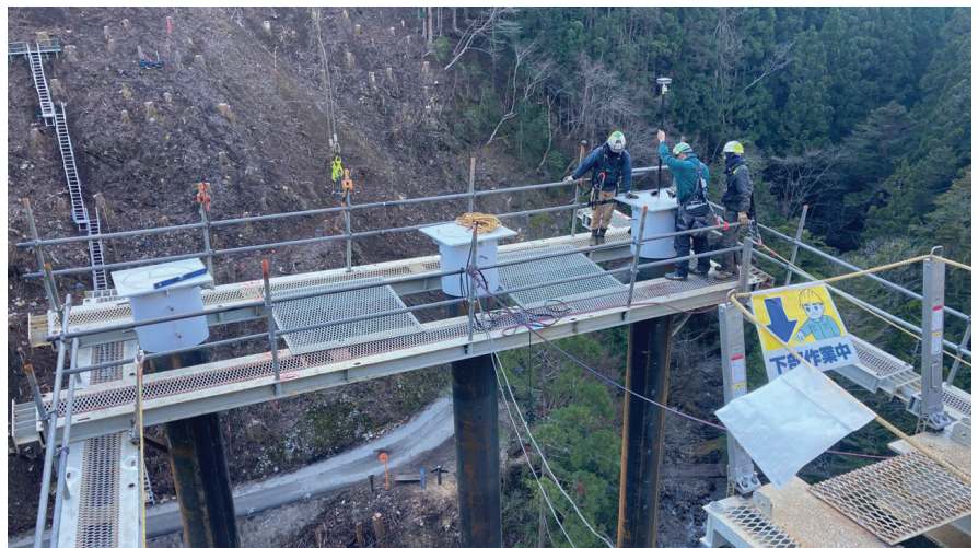
栈橋の作業状況
