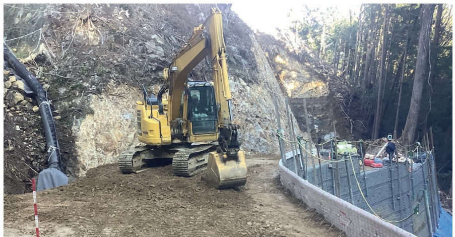
補強土壁(盛土)の作業状況
