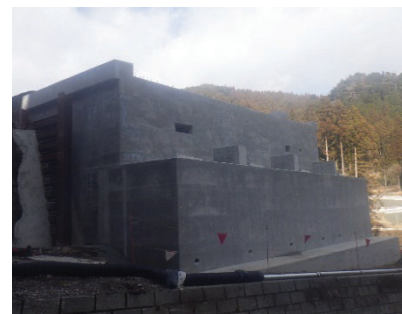
2号橋A1橋台
