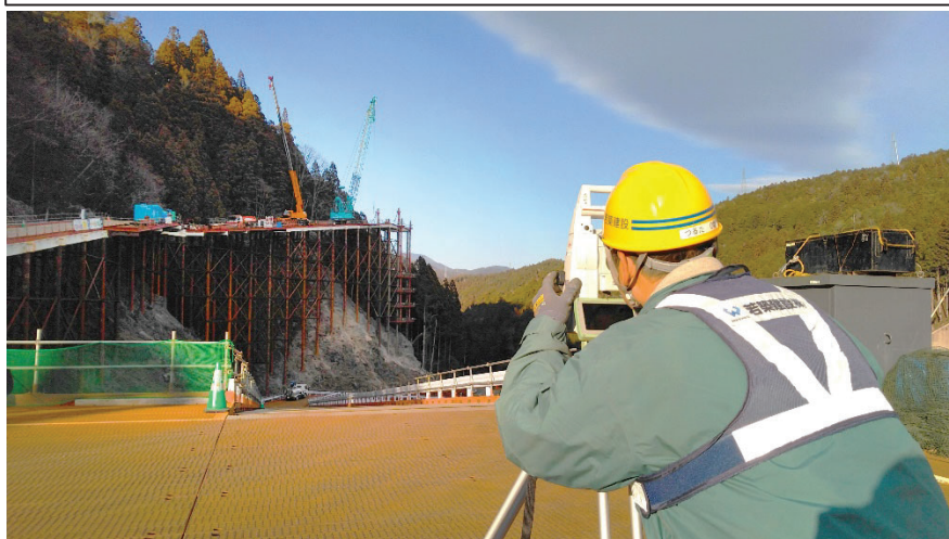
出来形確認測量状況
