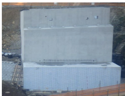
1号橋A2橋台
