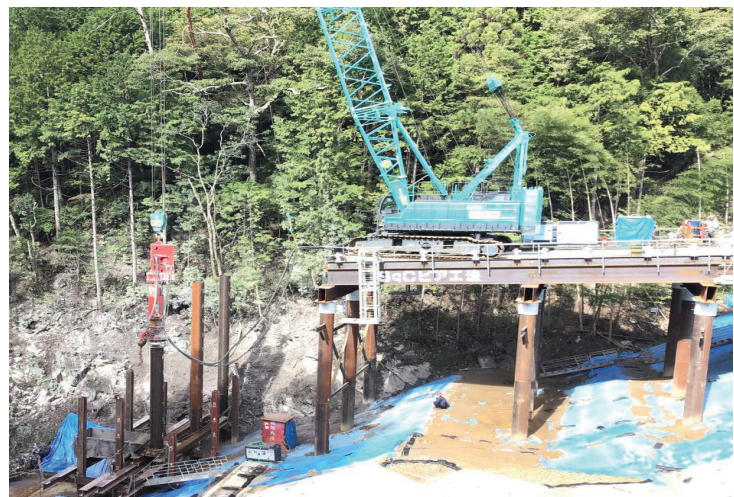
仮栈橋における支持杭打設状況
