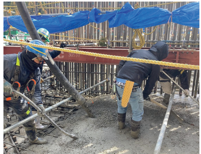
コンクリート打設の作業状況
