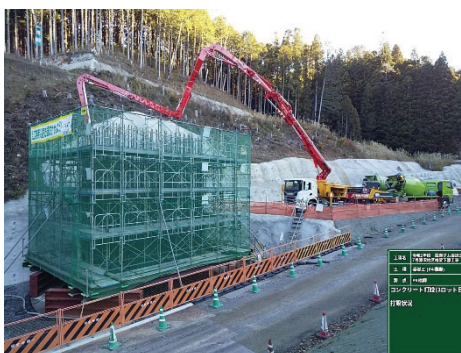
<コンクリート打設状況>
