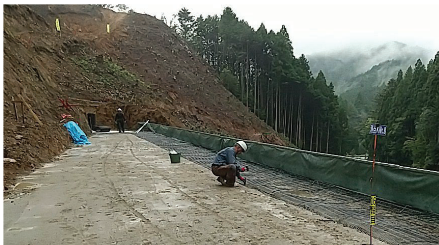
ジオテキスタイル補強土壁 補強材敷設作業状況
