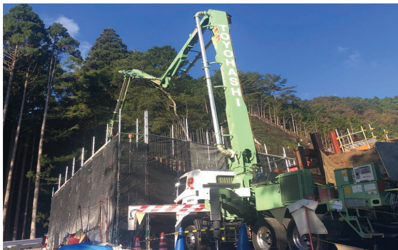
コンクリート打設状況(2号橋A1橋台)
