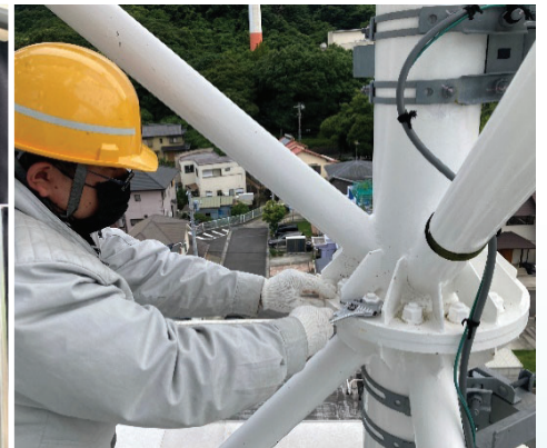
通信鉄塔の作業状況
