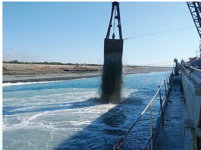
※海上養浜 養浜材投入状況
