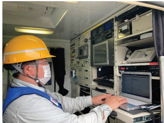
衛星通信設備の作業状況
