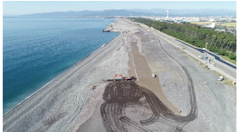
※陸上養浜施工箇所全景
