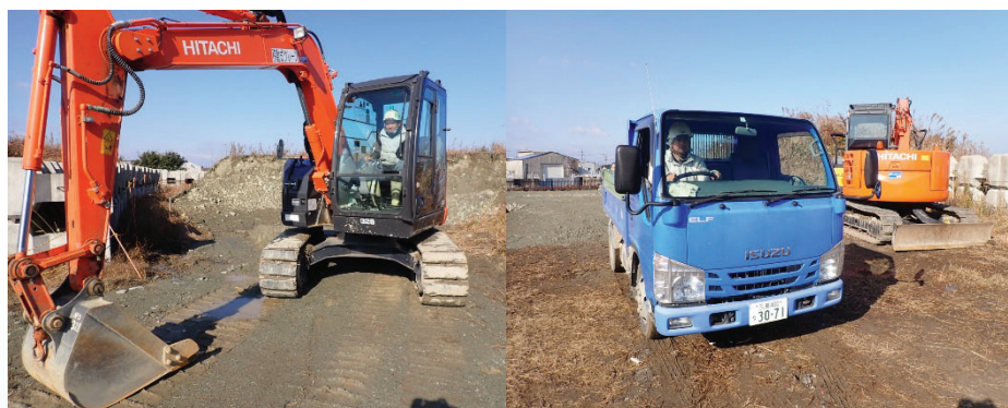
維持修繕工事の作業状況
