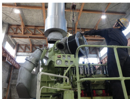
機器取り外し作業状況
