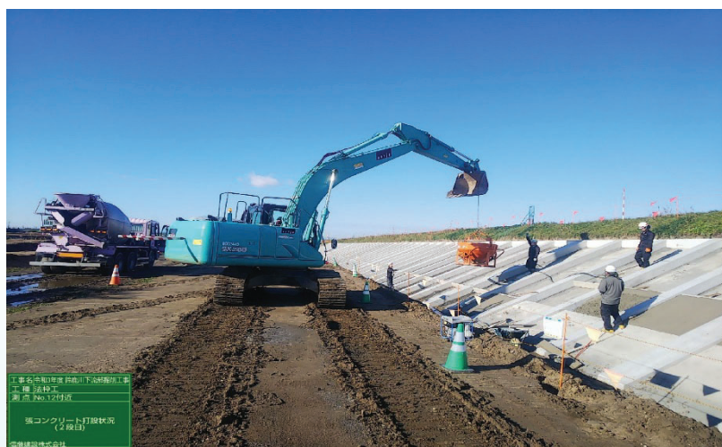
張コンクリートの打設作業状況
