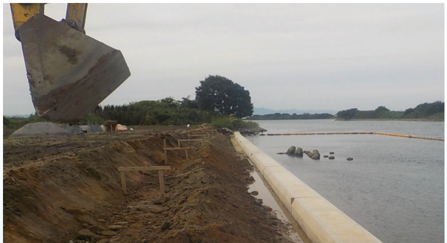
床掘りの作業状況
