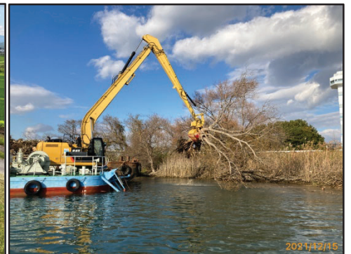
川岸の根株撤去状況
