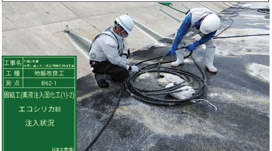
薬液注入の作業状況
