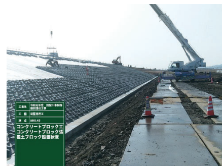
覆土ブロック 据付
