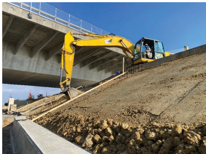
法面整形工 法面整形の作業状況
