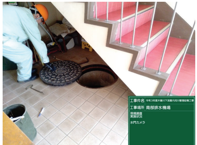
ケーブルルート調査
