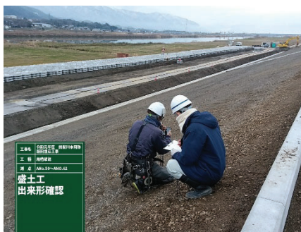
盛土工 出来形確認
