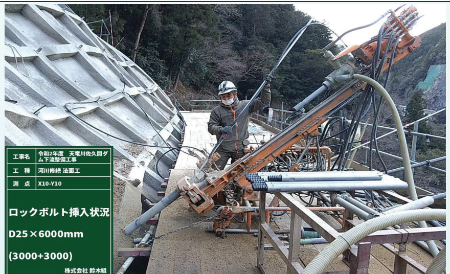
〔鉄筋挿入工〕 ロックボルト挿入状況
