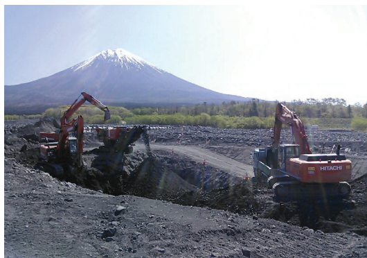
大沢遊砂地 掘削・粒径処理状況
