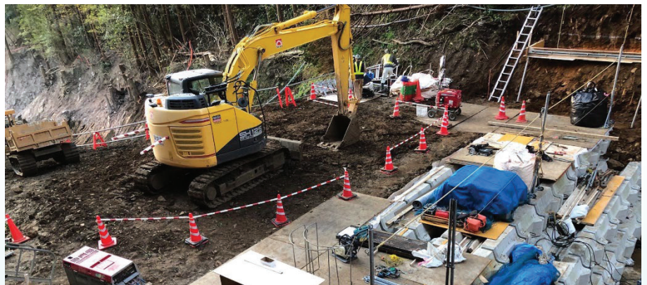
仮設堰堤の作業状況
