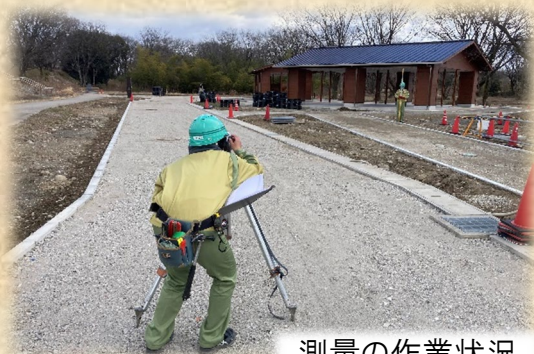
測量の作業状況
