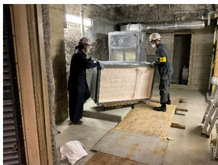
空気調和機搬入の作業状況
