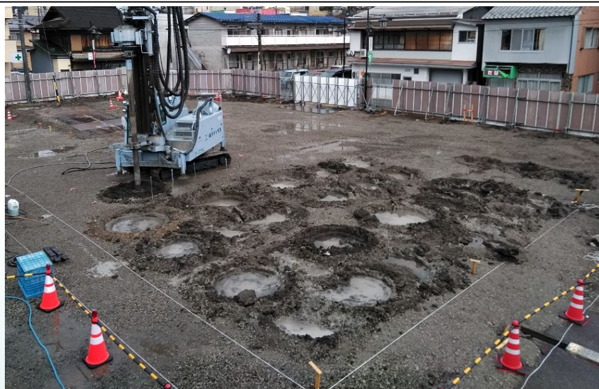
地盤改良工事の作業状況
