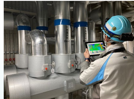
iPad活用による現場管理状況
