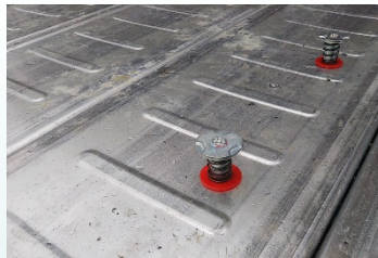
配線・配管用インサートの作業状況
