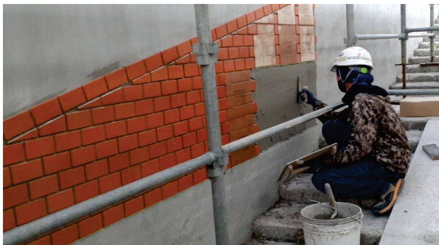
タイル張りの作業状況
