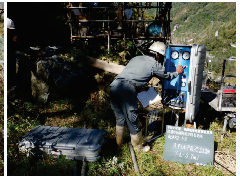
原位置試験の状況
