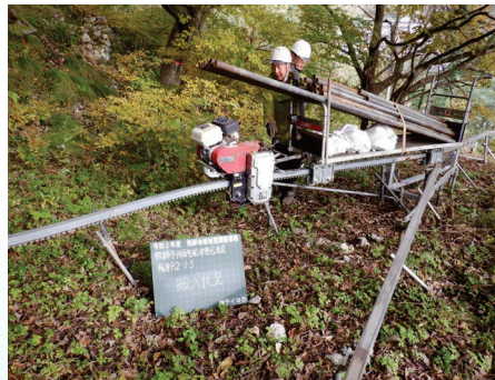
機材の搬入状況
