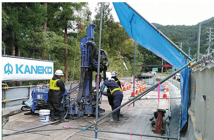
EPルートパイル削孔の作業状況
