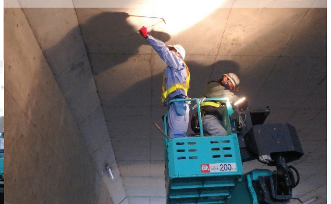
テストハンマーによる打音点検
