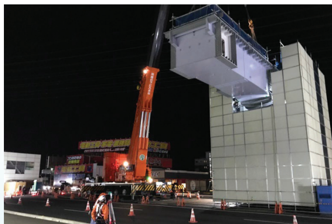
鋼製梁の架設作業状況
