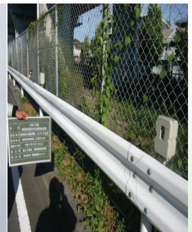
↑ 機械観測機器の設置状況(可搬式トラフィックカウンター)
