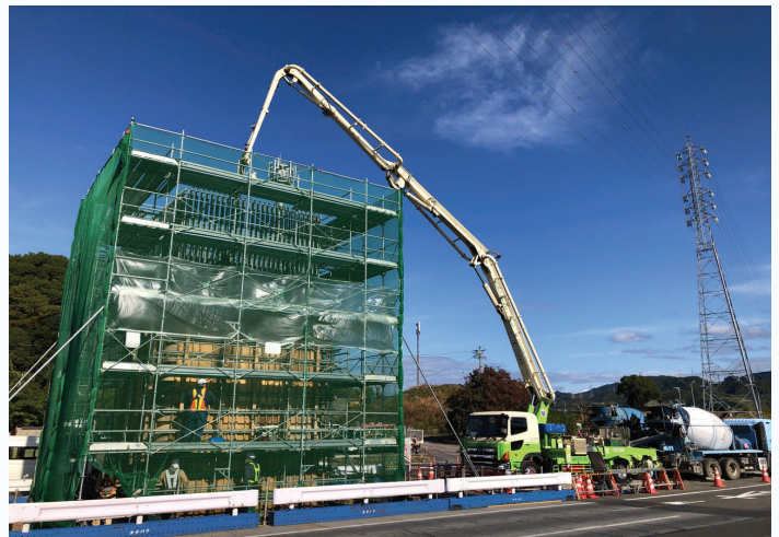
▷コンクリート打設状況
