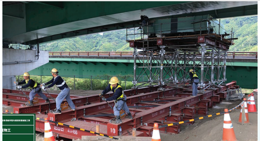
変位制限装置引き込みの作業状況
