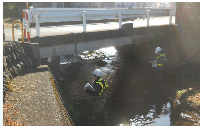
点検講習会に向けた現地踏査
