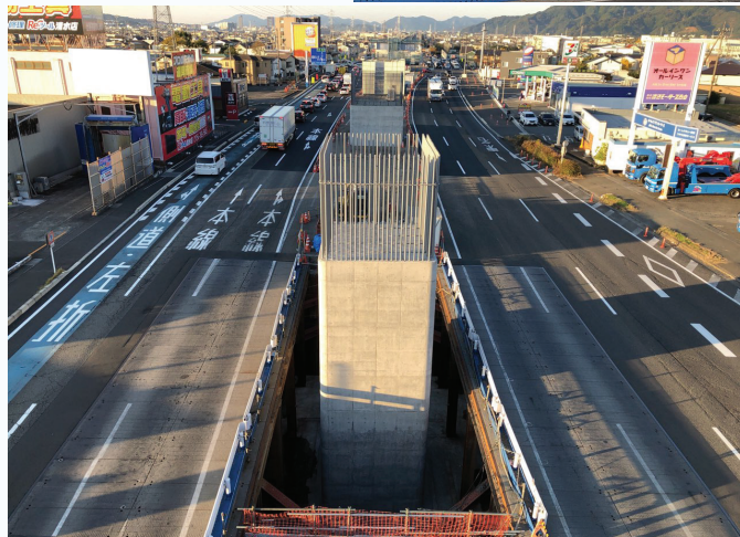
◁P 29 橋脚完成写真
