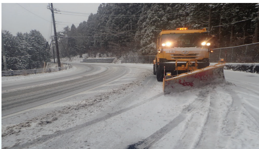
除雪の作業状況
