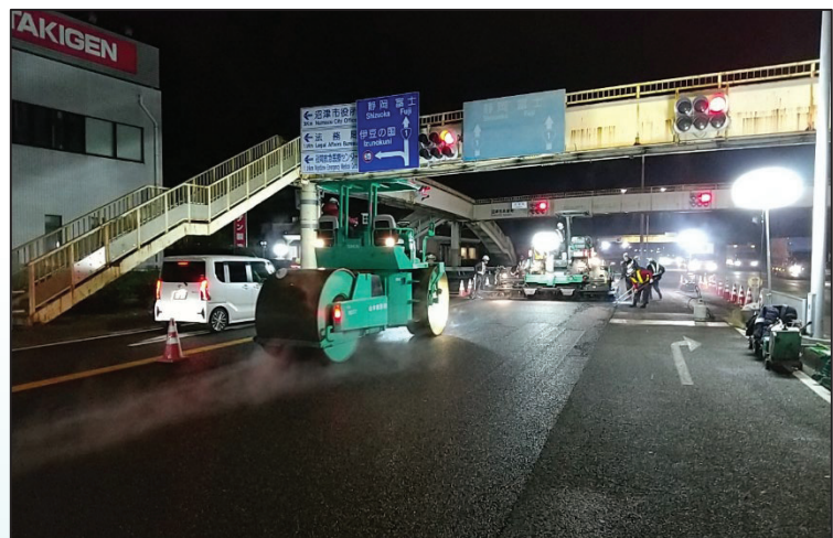
舗装舗設・転圧状況
