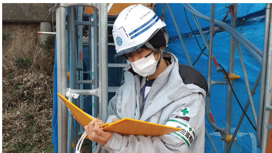
安全巡視状況
