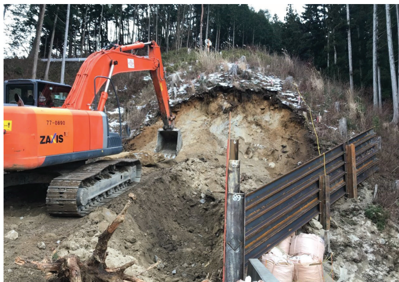
終点側坑口掘削の作業状況
