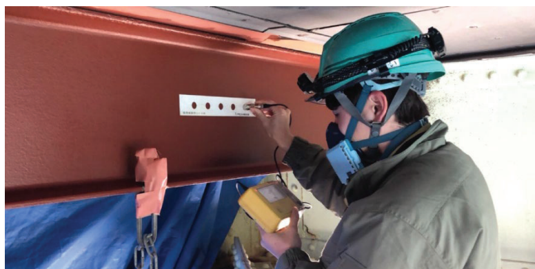
塗膜厚測定状況
