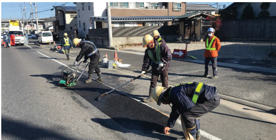
舗装工事の作業状況
