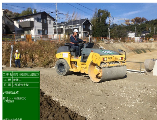
補強土壁の作業状況
