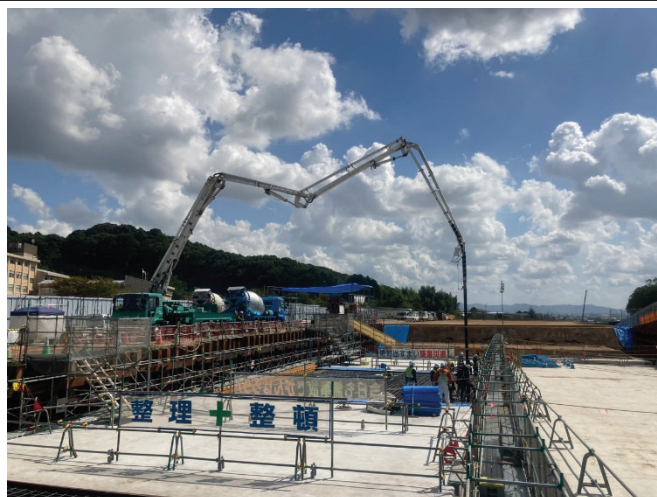
カルバート工の構築作業中
