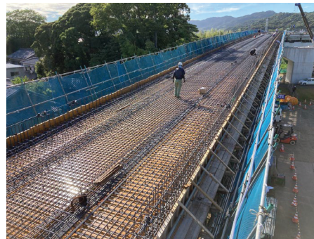
床版鉄筋組立状況
