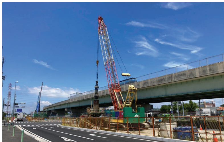
場所打杭の掘削作業状況
