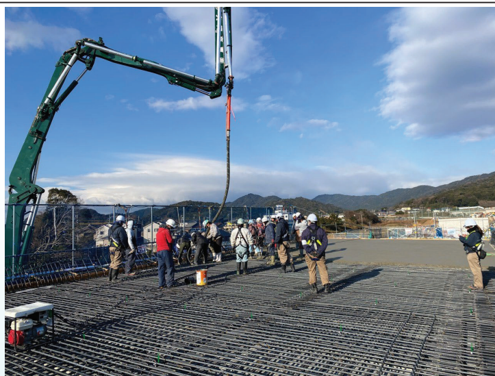
コンクリート打設状況
