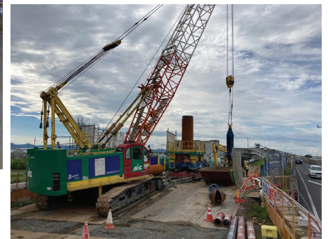
橋脚基礎杭施工状況
