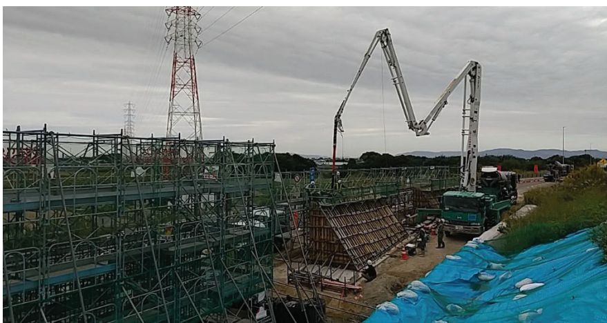
重力式擁壁の打設状況
