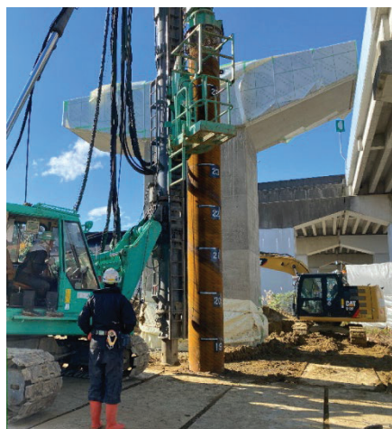
鋼管杭 削孔状況→
