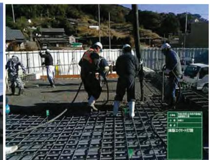
側道橋：桁組立・架設、床版打設状況
