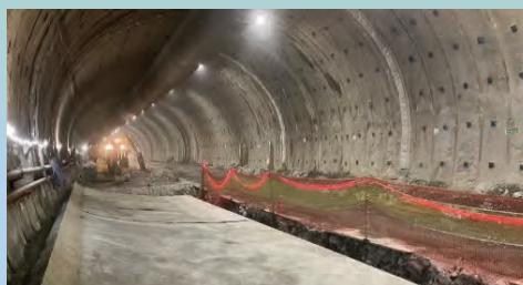
インバート工(打設完了)
