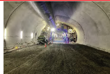
覆工 (セントル) 打設後
