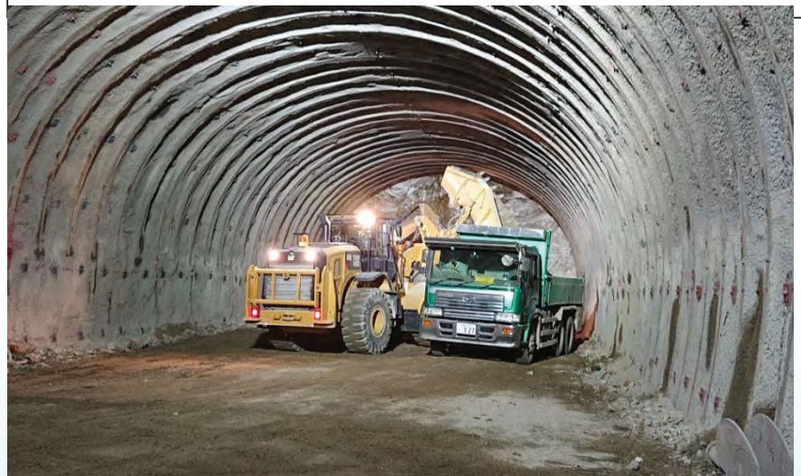
ずり運搬状況
