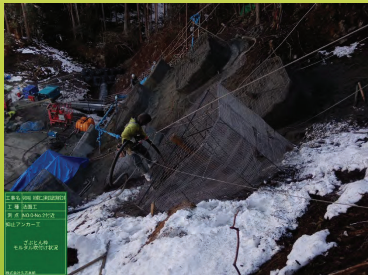
法面でのグラウンドアンカー吹付の作業状況
