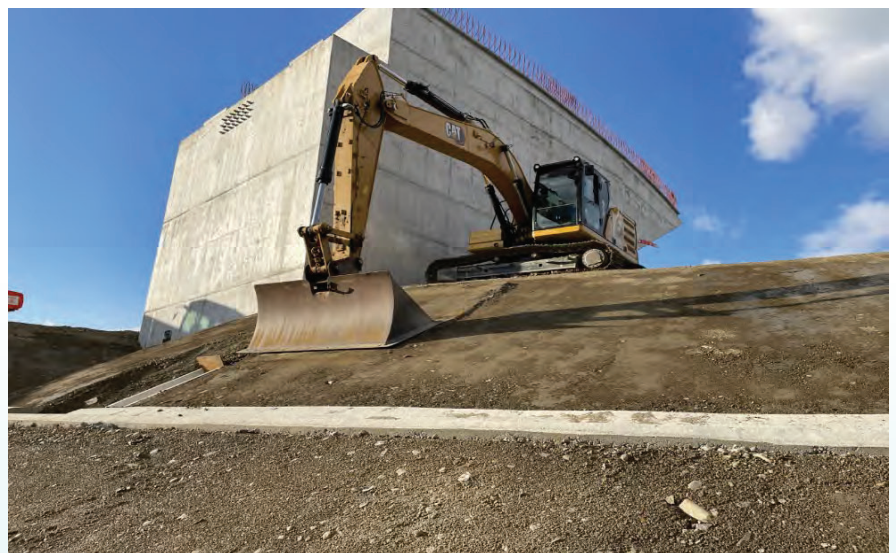
ICTバックホウによる法面整形状況
