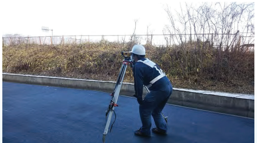
測量の作業状況
