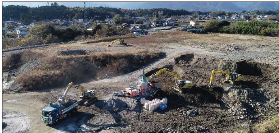
石灰系材料で攪拌する改良工事
