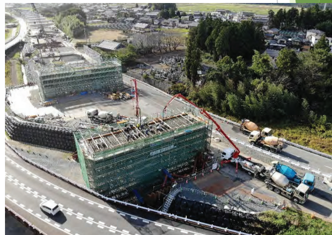
梁部コンクリート打設状況
