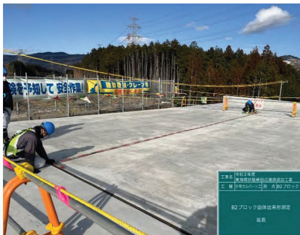
BOXカルバート出来形測定
