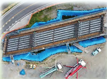
PCホロースラブ本体打設前全景・打設状況
