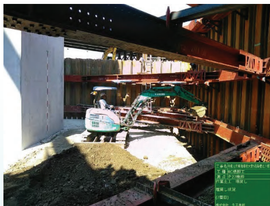
埋戻しの作業状況
