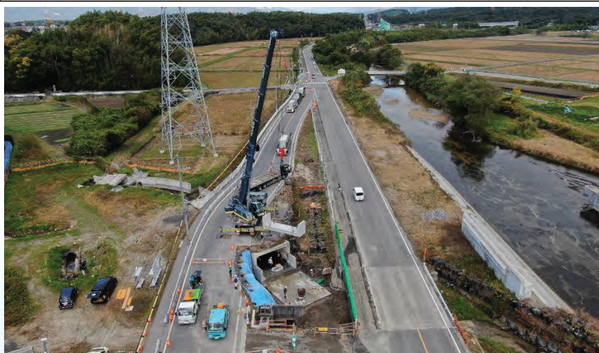
プレキャストカルバート据付作業状況
