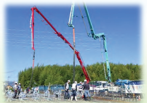
PCホロースラブ本体打設前全景・打設状況
