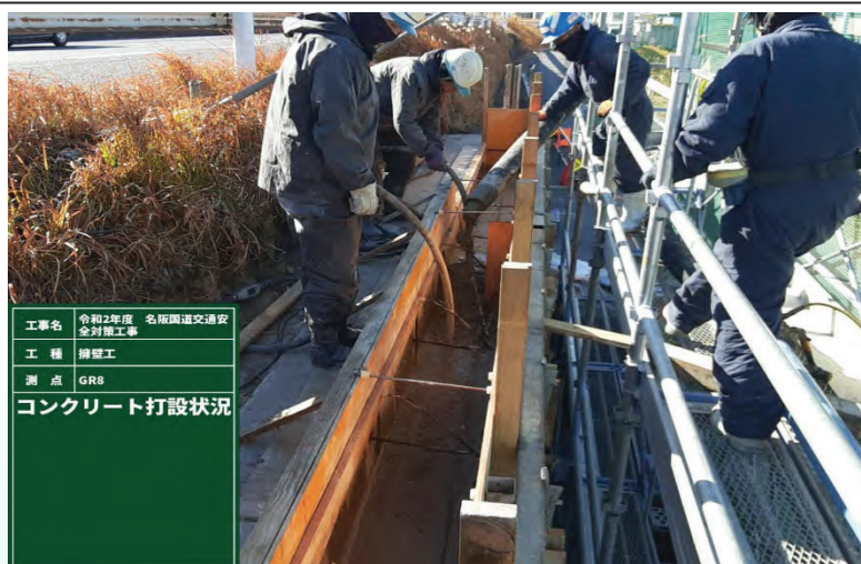
コンクリート打設状況
