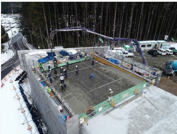
コンクリート打設の作業状況
