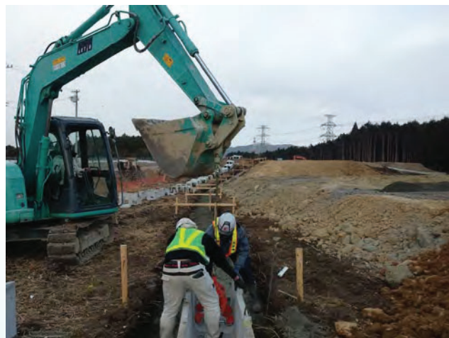
PU型側溝据付状況
