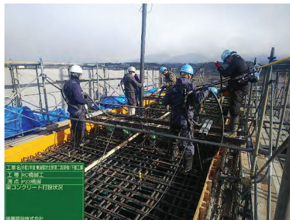
梁コンクリート打設作業状況
