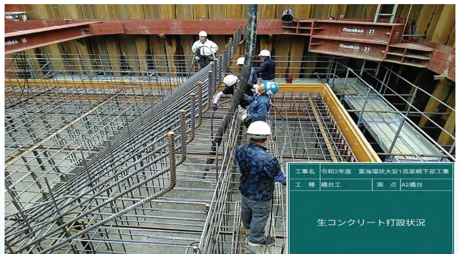
橋台躯体工、生コンクリート打設の作業状況
