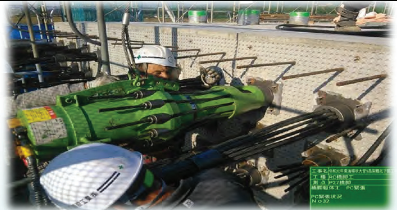
橋脚躯体工・PC緊張工 PCケーブル緊張作業状況
