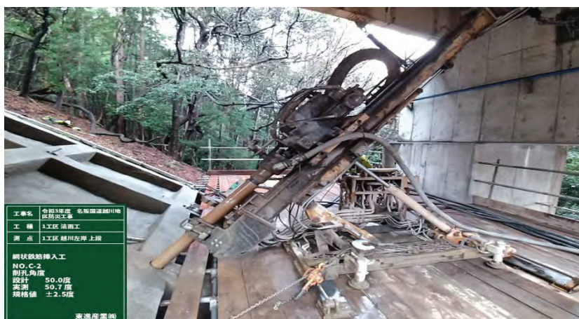
網状鉄筋挿入工:削孔角度測定
