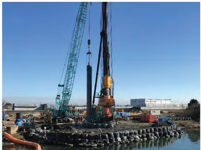
P1橋脚 鋼管矢板基礎工施工状況
