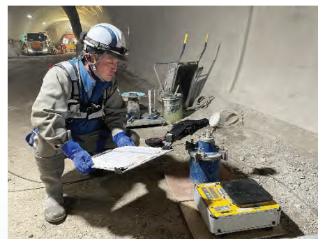
品質管理実施状況 (覆工コンクリート打設時)
