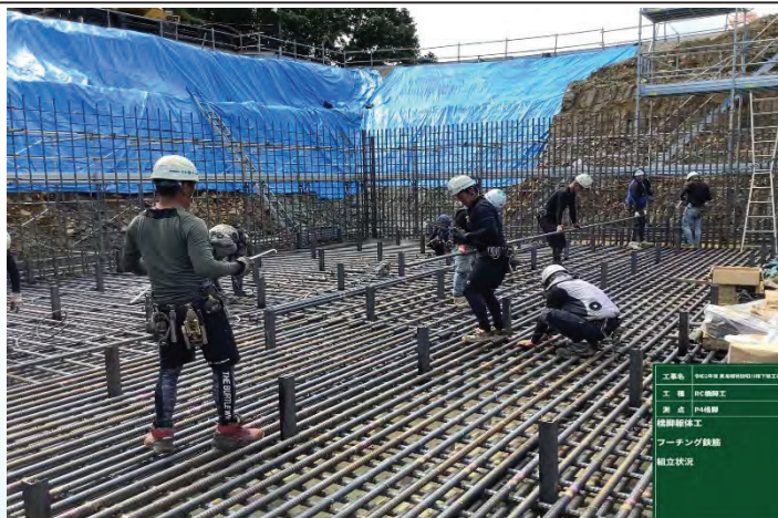
鉄筋組立の作業状況
