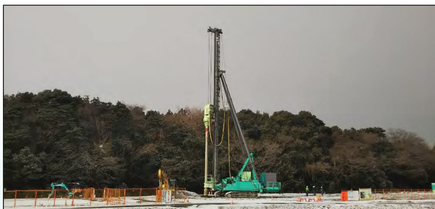
セメント系攪拌地盤改良工事
