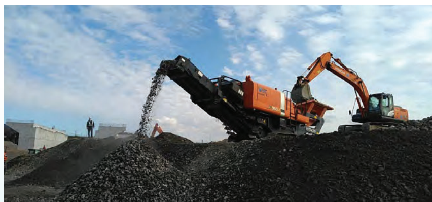
盛土材破碎の作業状況
