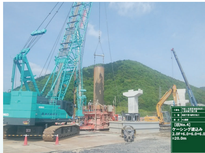
場所打ち杭作業状況
