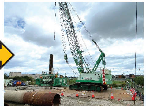
実際の作業状況
