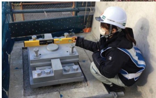
支承の出来形計測
