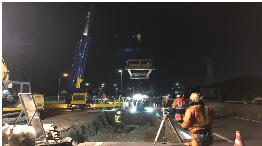
覆工板設置の作業状況
