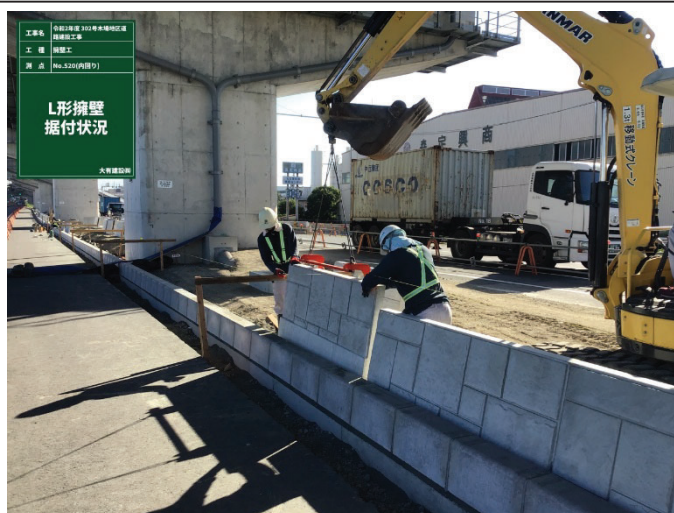
L型擁壁の作業状況
