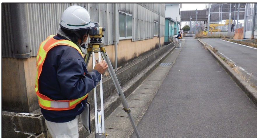
定期水準測量の作業状況
