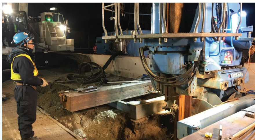
鋼矢板の作業状況
