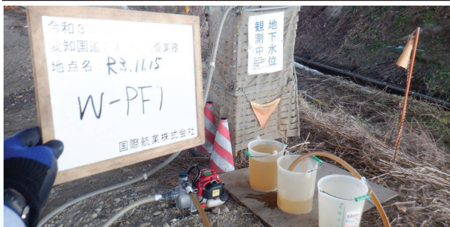
観測井戸から地下水を揚水している状況
