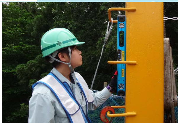
クレーンを垂直に設置
