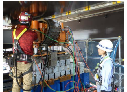
送出し装置の点検中
