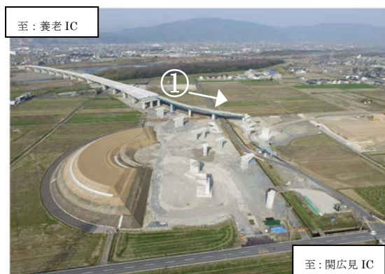
写真①：床版型枠組立完了時
