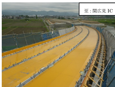
写真①：床版型枠組立完了時
