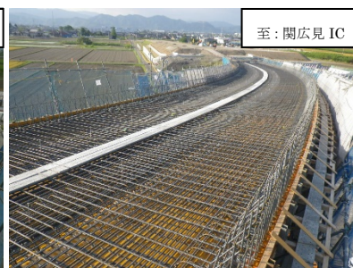
写真②：床版鉄筋組立完了時
