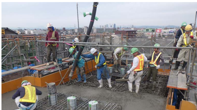
梁コンクリート打設状況
