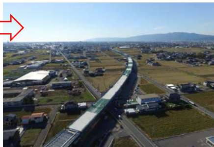
床版コンクリート打設完了
