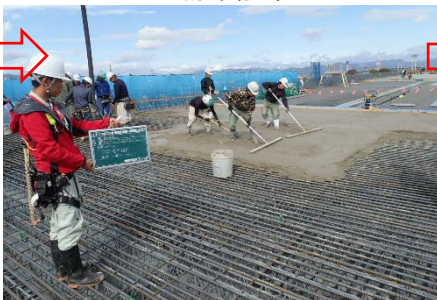
床版コンクリート打設中
