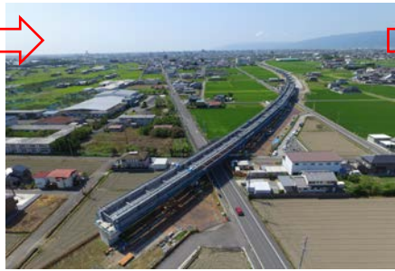
主桁架設完了
