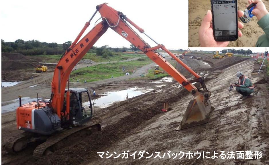
マシンガイダンスバックホウによる法面整形
