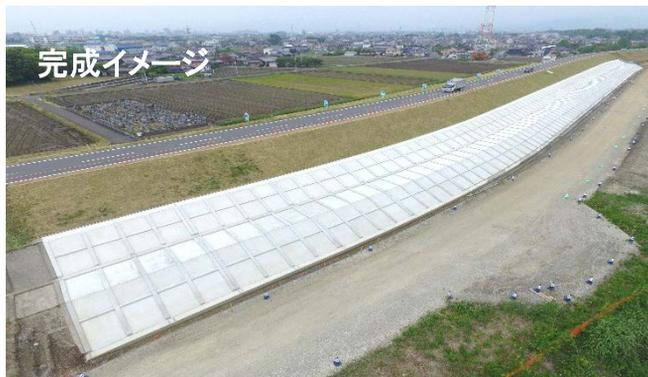
既存の堤防法面に盛土を行い、コンクリート護岸を施工する工事です。コンクリート護岸は洪水時に堤防の洗堀を防ぎ、堤体内への水の浸透を防ぐ効果があります。
