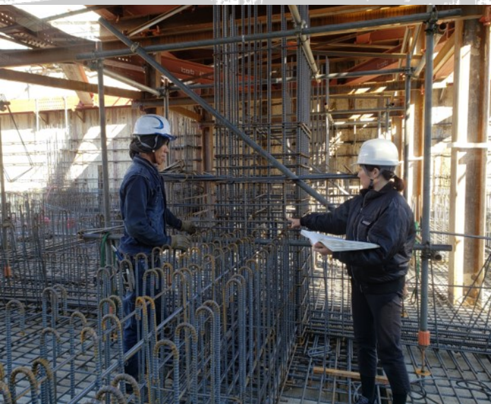
配筋の検査中
