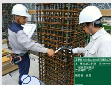
配筋の検査中
