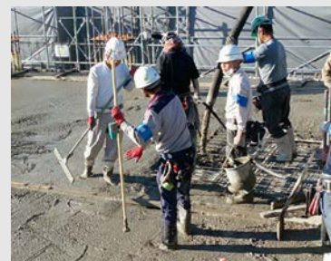
コンクリートの打設状況を確認中
