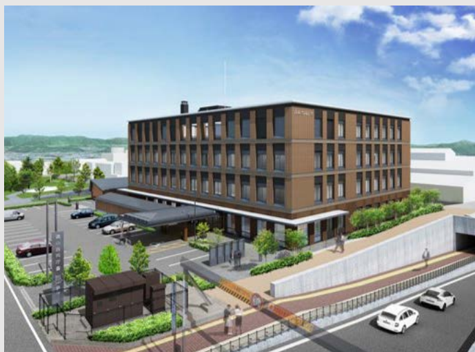
高山地方合同庁舎
