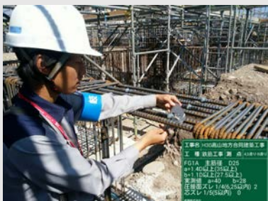
配筋の検査中
