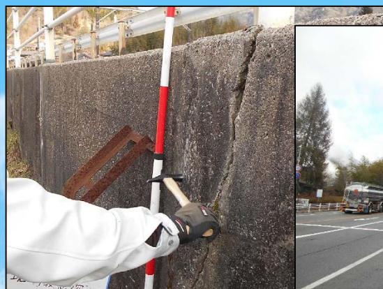
打音検査状況
